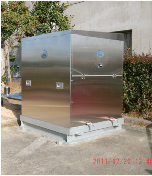
敷地北側に設置されたきわみ MI-64T 来館者は誰でも見ることができます
